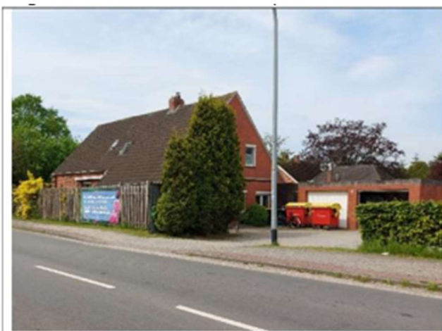
Ansicht von der Straße (NO)
